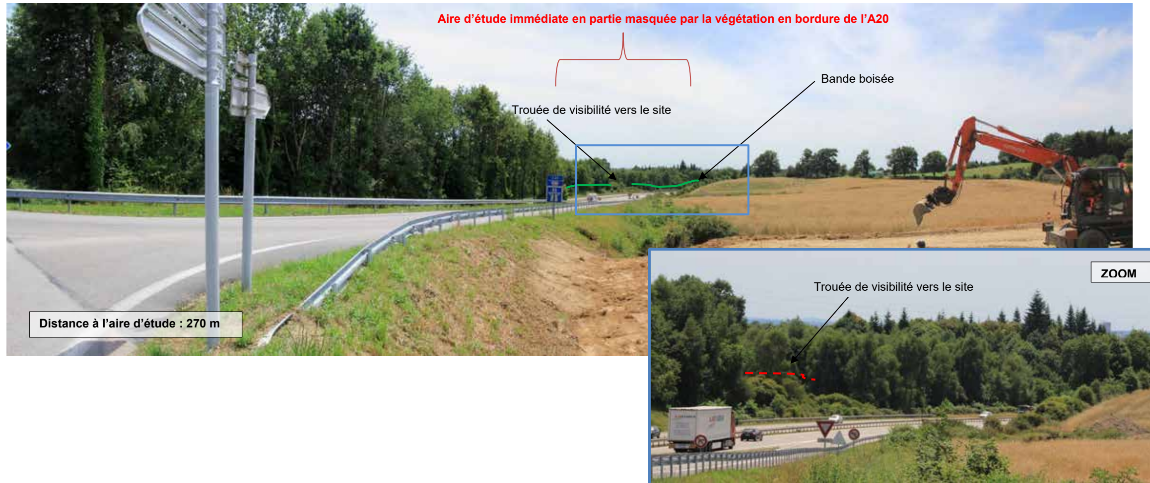
Photo 47 : Prise de vue n°9 depuis la RD97 au niveau de la rampe d'accès à l'A20 (zone de parking de covoiturage en construction)
