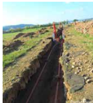
Photo 7 : Tranchée pour câblage
