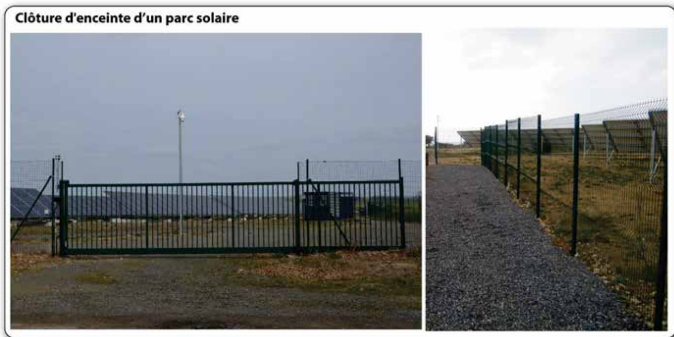
Photographie 9 : Clôture de sécurité
