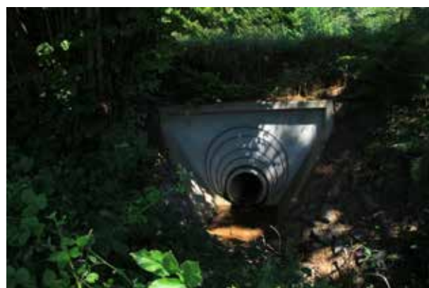
Photo 79 : Ouvrage de gestion des eaux pluviales sous la RD 220
