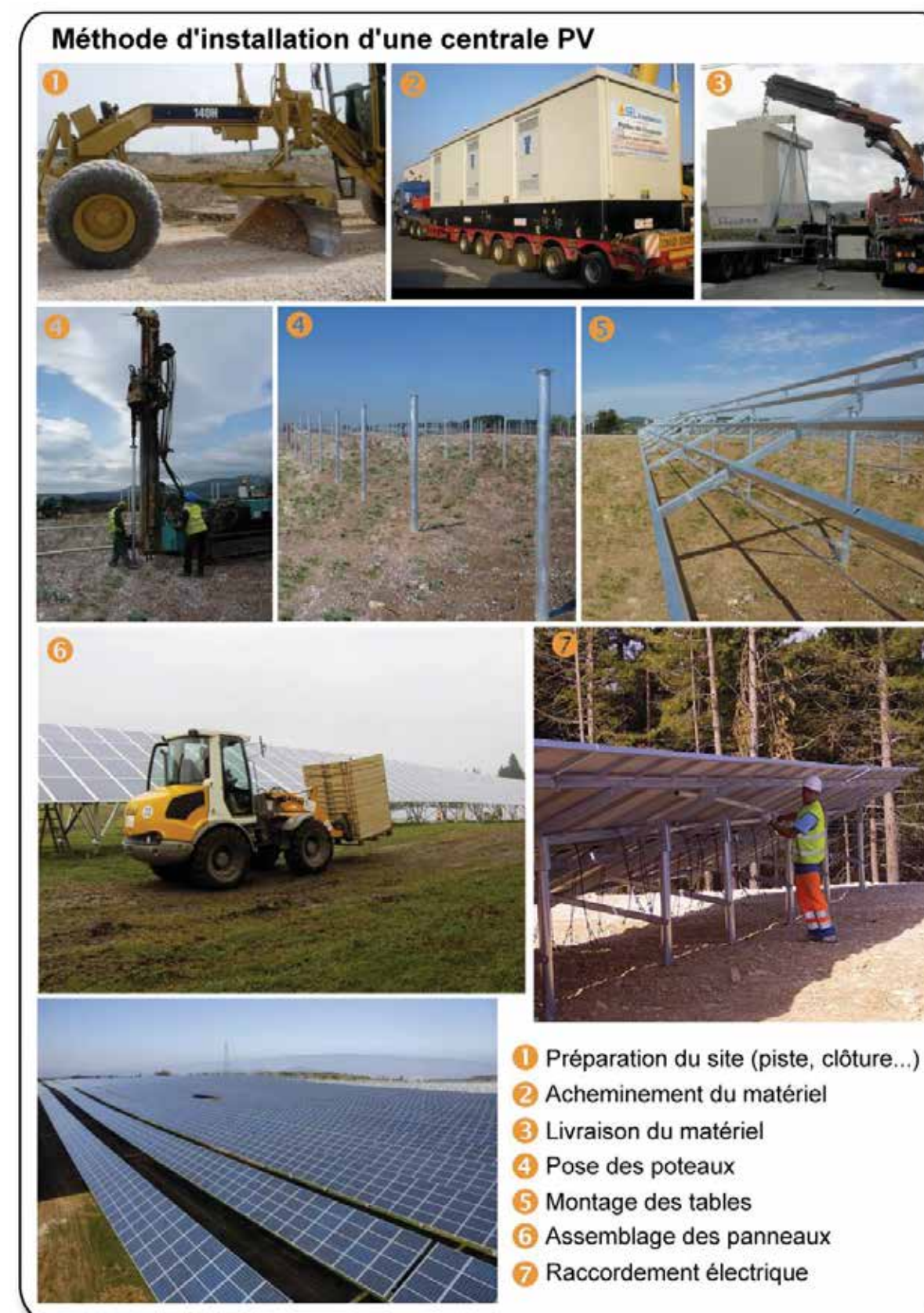
Photographie 10 : Construction d'une centrale photovoltaïque
