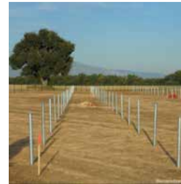
Photo 3 : Vis d'ancrage
